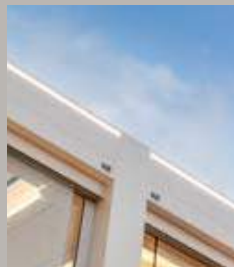
Iluminación con luces LED integradas permite una iluminación de luz reflejada: interna, exterior
