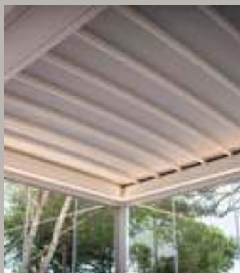
TECHO ARQUEADO la forma de arco rebajado del techo permite disminuir las dimensiones de altura además de mejorar el aspecto estético
